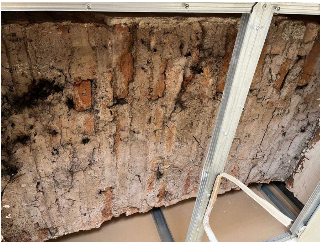
Фото 4. Перемычка над дверным проёмом
